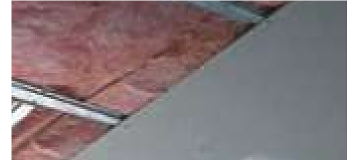
Losa maciza de concreto armado Colchoneta de fibra de vidrio 4 Canales listón Plafón Tablaroca aislante térmico Marca USG 45cm
